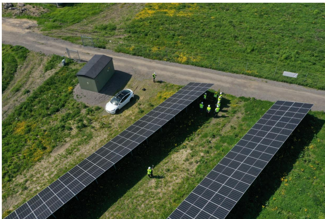
Figur 7. Foto på solpaneler, transformatorstation, nya vägar och stängsel i solpark Varberg norra, Solkompaniet ©.
