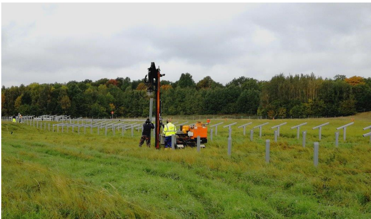
Figur 3. Exempelbild pålningsmaskin för infästning av pålar i marken.
