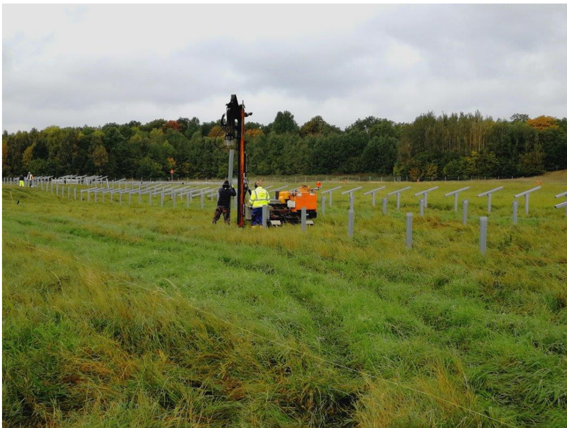
Figur 6. Exempelbild pålningsmaskin för infästning av pålar i marken.
