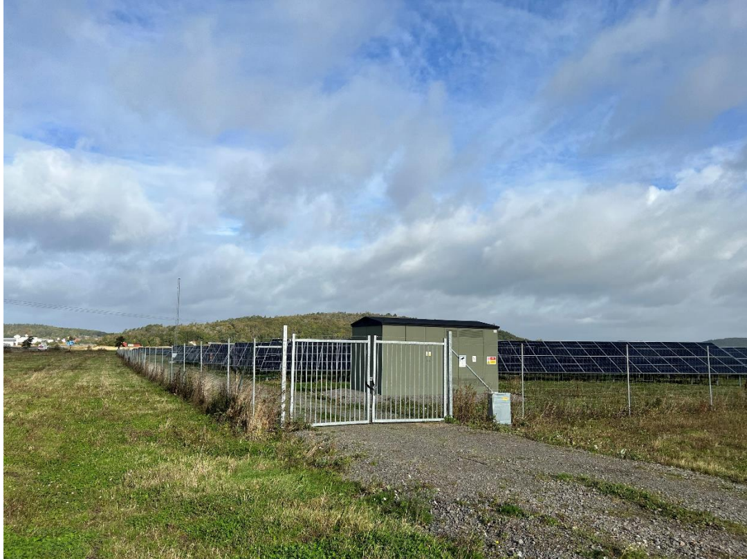
Figur 5. Exempel på staket och grind vid infarten till Solpark Varberg norra.
