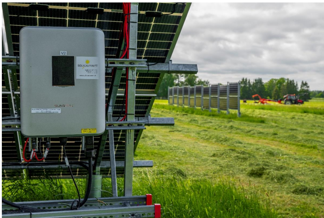
Figur 12. Exempelbild på växelriktare (källa: Solkompaniet).
