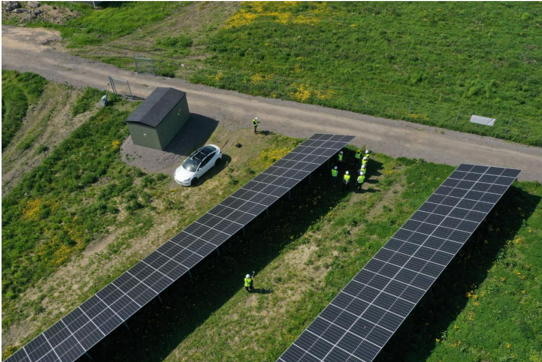
Figur 13. Foto på solpaneler, transformatorstationer, nya vägar i parken och stängsel i Solpark Varberg norra (källa: Solkompaniet).
