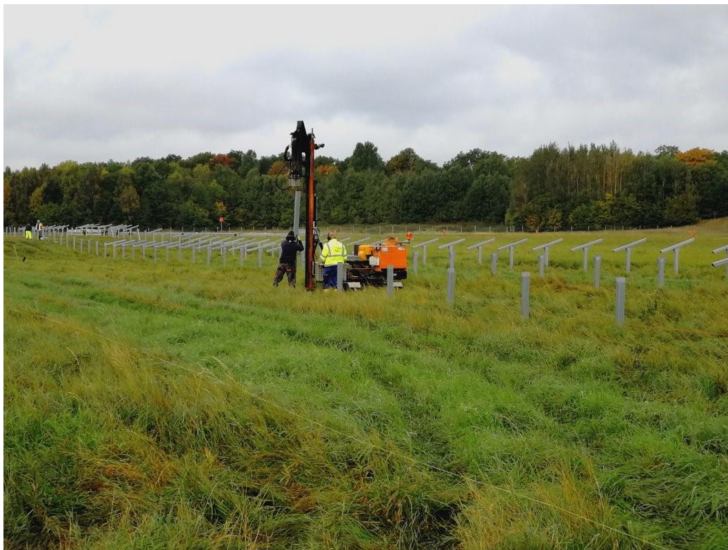
Figur 10. Exempelbild pålningsmaskin för infästning av pålar i marken (källa: Solkompaniet).
