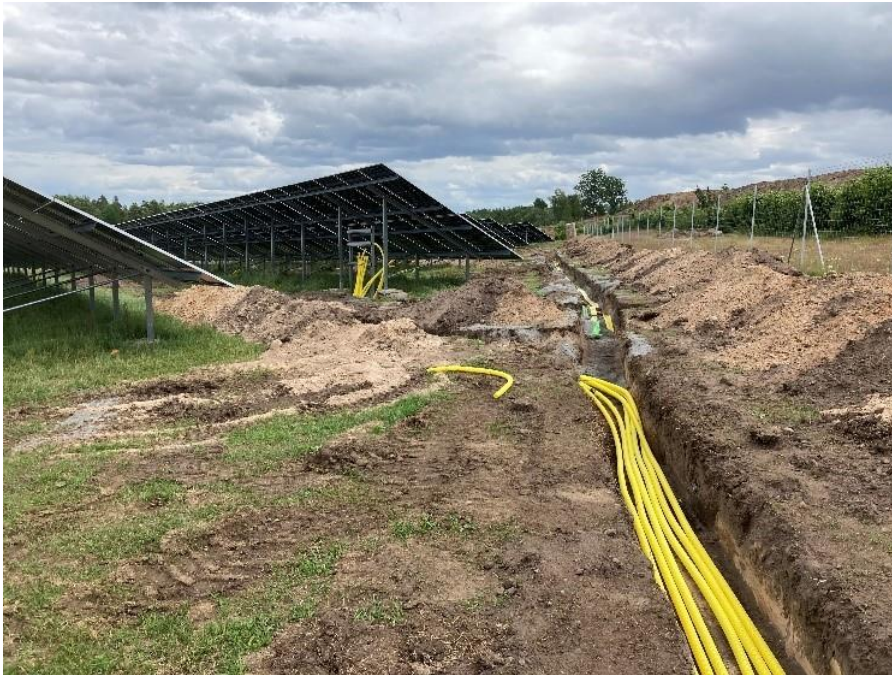
Figur 14. Exempel på grävda kabelschakt (källa: Solkompaniet).
