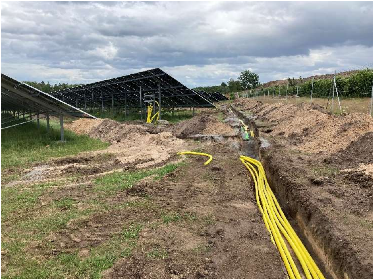
Figur 17. Exempel på grävda kabelschakt i solpark.
