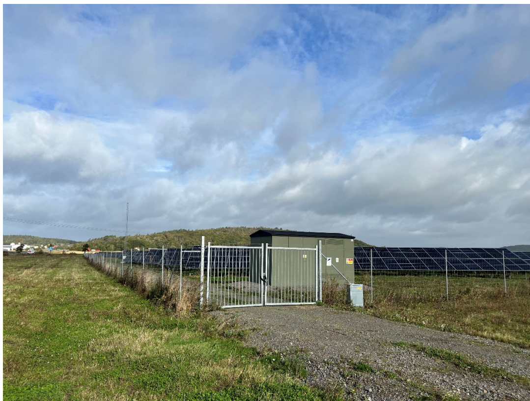
Figur 5. Exempel på stängsel och grind vid infarten till Solpark Varberg norra.
