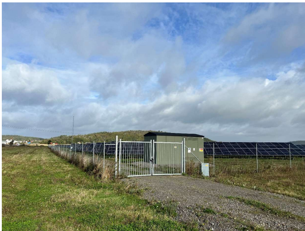
Figur 6. Exempel på stängsel och grind vid infarten till Solpark Varberg norra.
