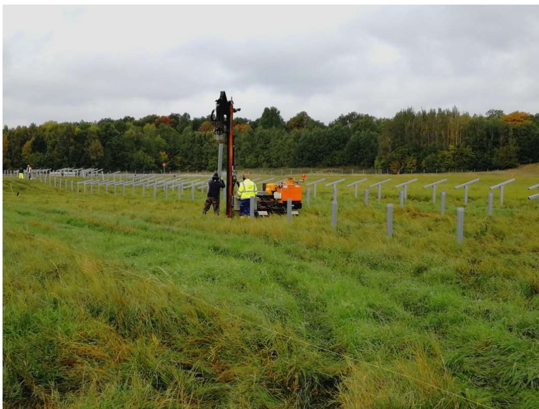
Figur 7. Exempelbild pålningsmaskin för infästning av pålar i marken.
