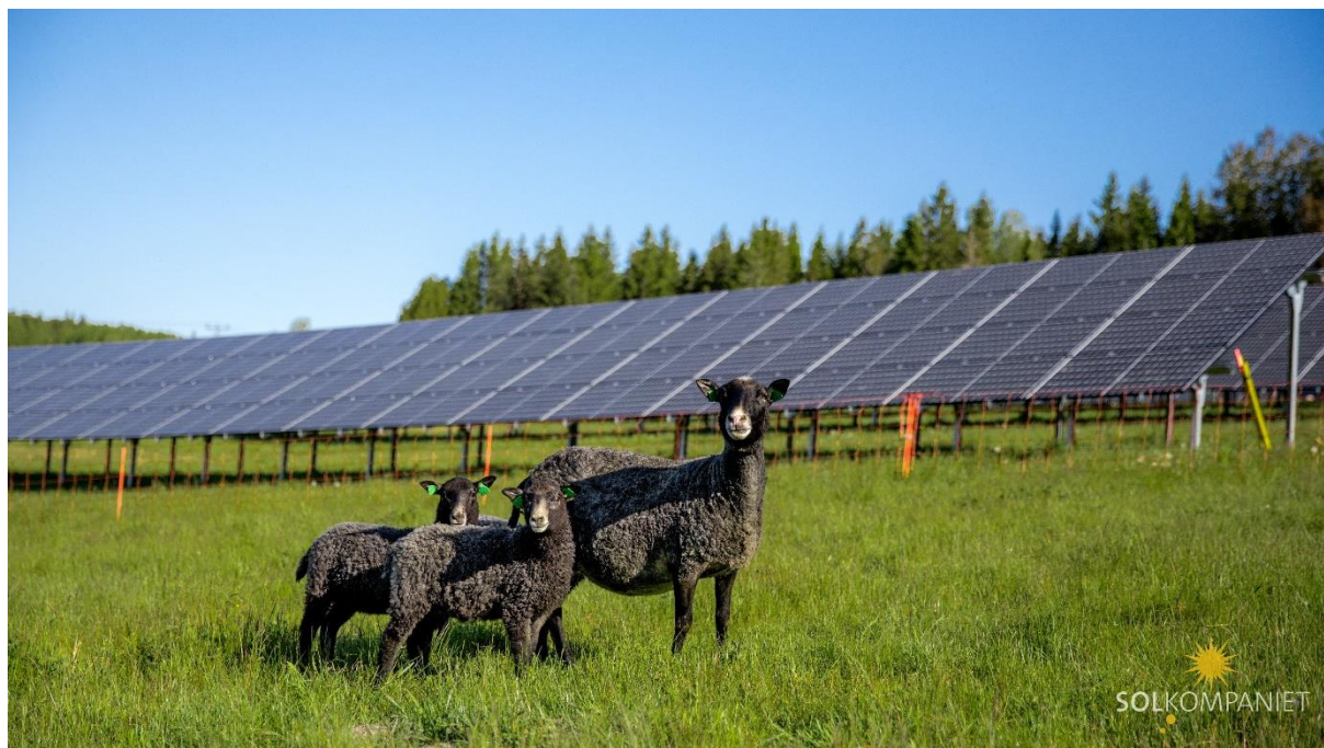
Figur 1. Foto från Linde Energis solpark i Torphyttan som Solkompaniet har byggt.
