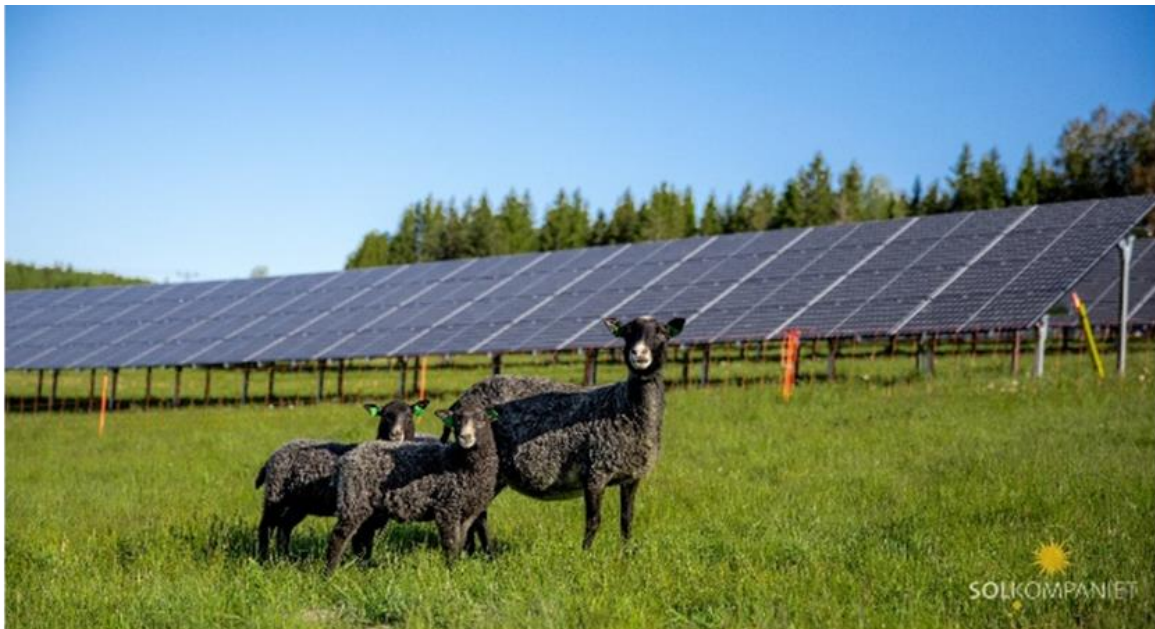
Linde Energis solpark i Torphyttan som Solkompaniet har byggt
