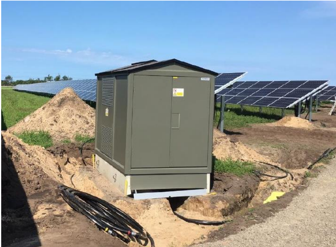
Figur 8. Exempelbild transformatorstation under byggnation av solpark i Varberg. Även en del av schakt är med på bild.
